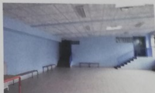
Réfection du préau de l'école Joliot Curie
