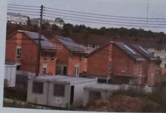
Les réseaux électriques vont être enfouis prochainement
