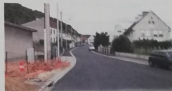
Mise en souterrain des réseaux rues Lénine et de Condé
