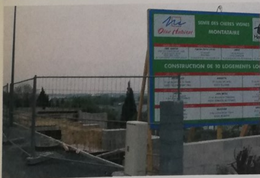
Chantier des Chères Vignes
