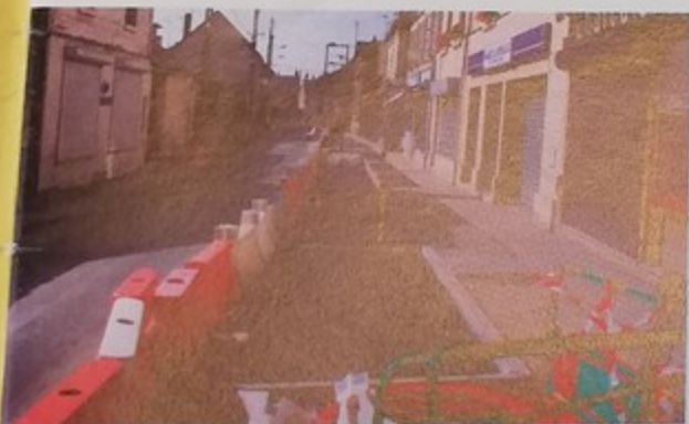
3 ème tranche des travaux du centre ville, rue de la République
