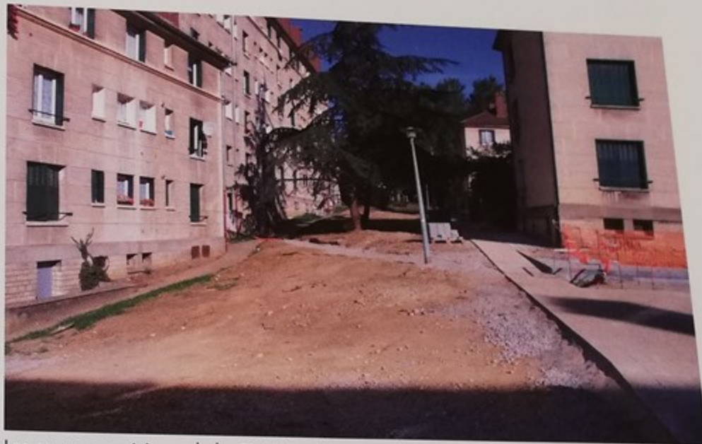
Les espaces extérieurs de la Cité Biondi ont commencé à être réaménagés
