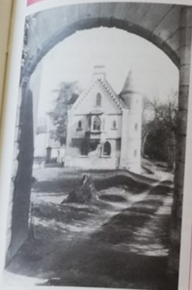
Petit château de Montataire (parking privé)
