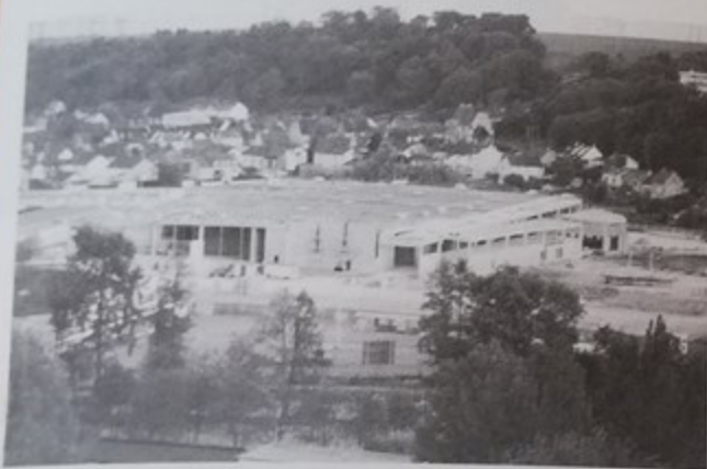
Construction en cours du nouveau centre commercial Leclerc
