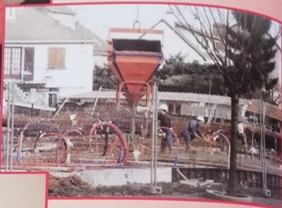
Chantier de la Résidence de la Tournelle rue Jean Jaurès
