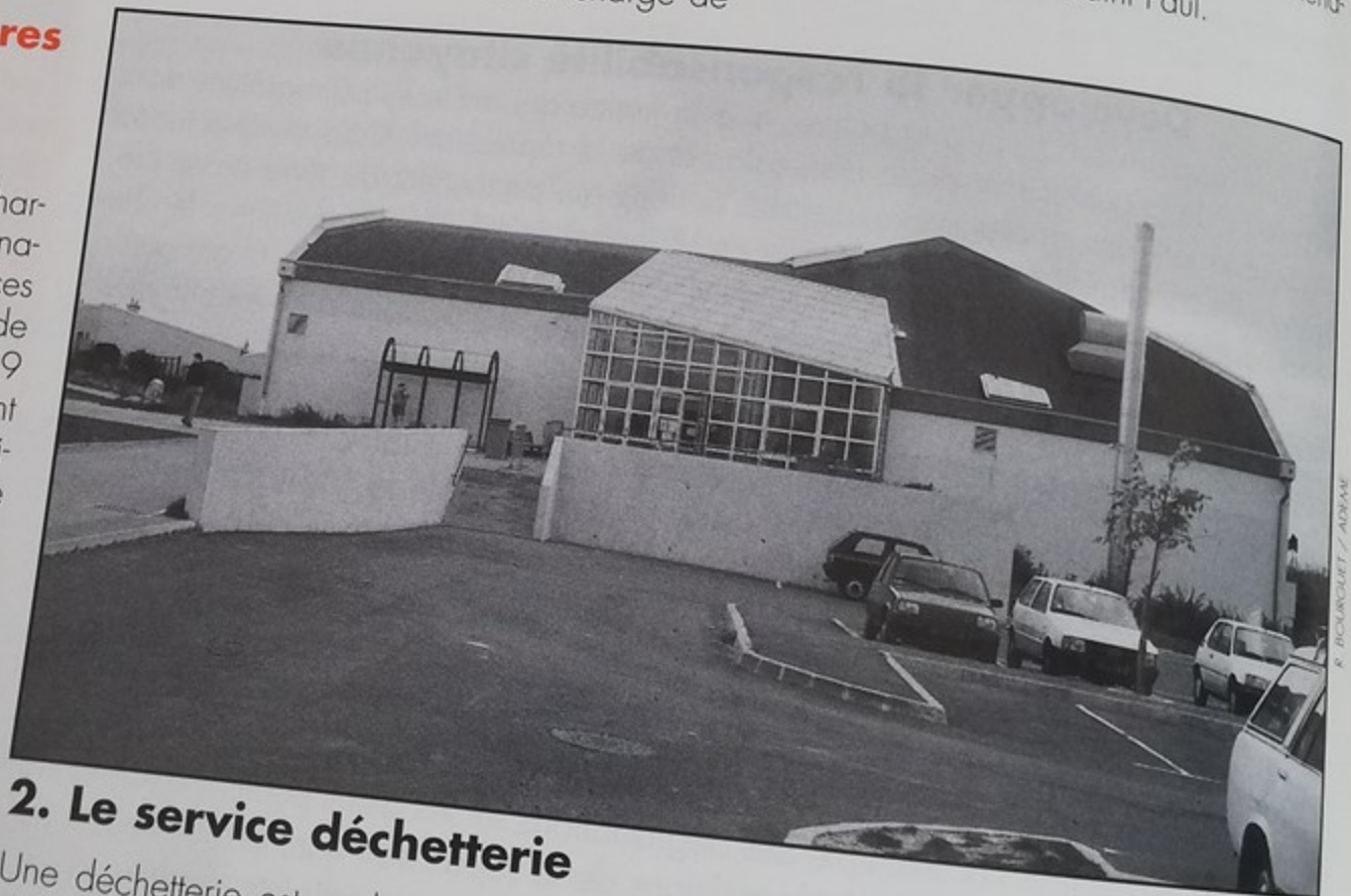
La déchetterie de Ligny (45)
