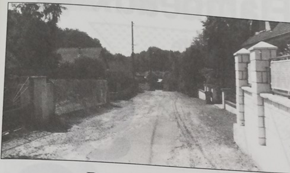
Remise en état du Chemin de Flageole
