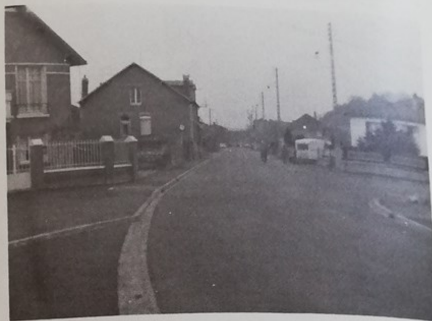
La rue Louis Blanc après réfection
