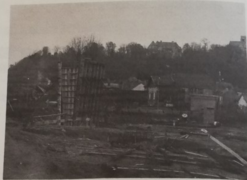
Vue des travaux en cours
