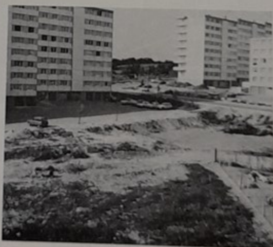
C'est sur cet emplacement en plein cœur de la Cité H.L.M. que la crèche sera construite
