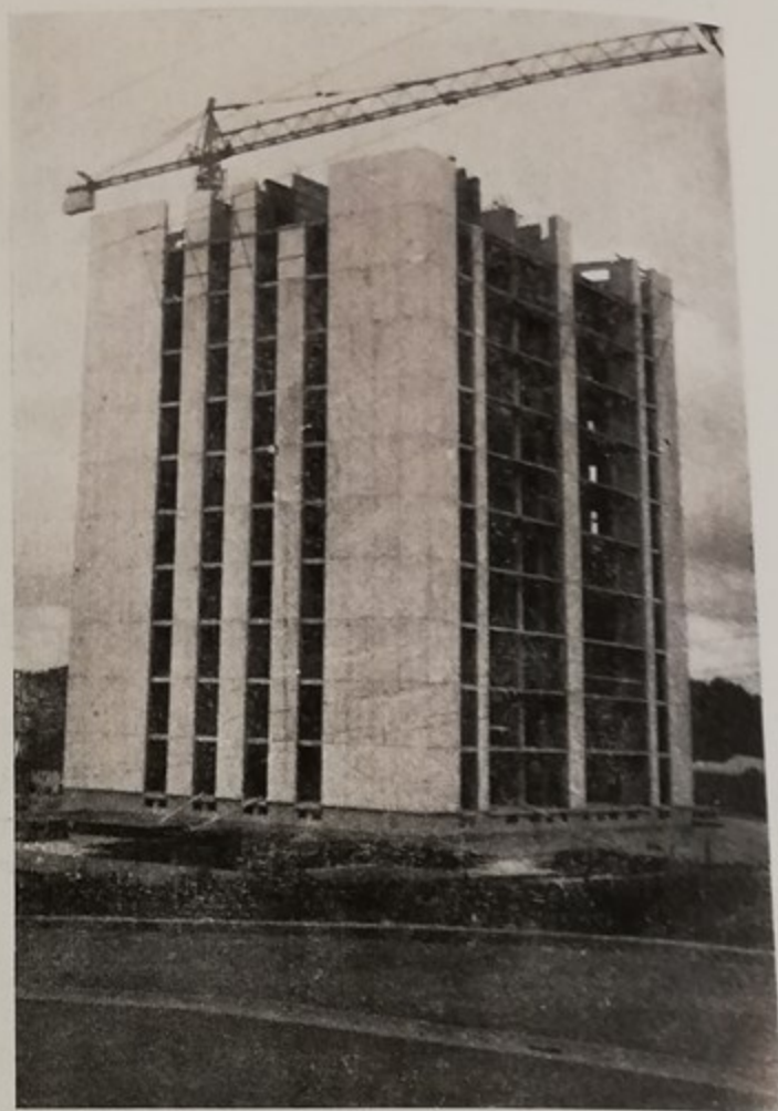
La tour continue. Le gros œuvre sera bientôt terminé
