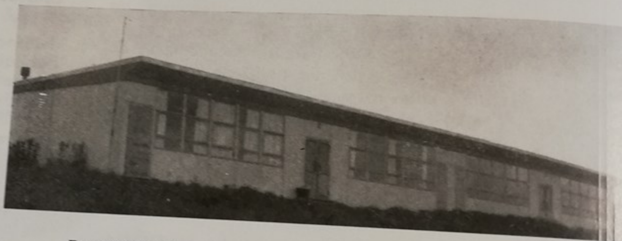
En attendant la construction d'une véritable Maison de Jeunes qui fait vraiment défaut à notre ville 4 classes préfabriquées qui étaient au groupe P. Langevin vont être remontées près de la Cité des Martinets
