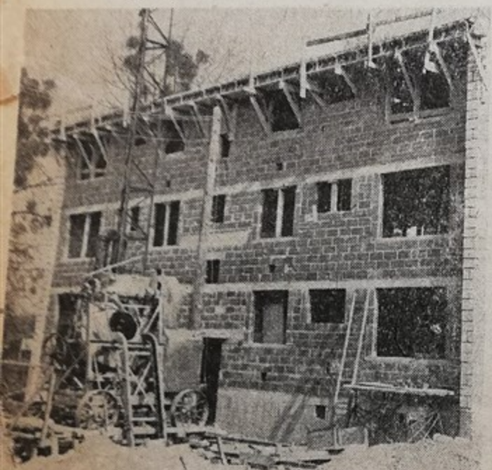
L'état des travaux des logements pour les instituteurs du groupe Joliot-Curie
