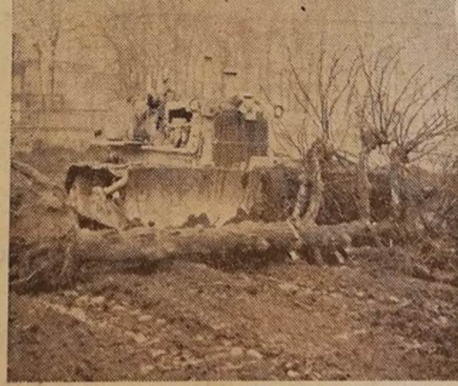
Il en avait vu passer des centaines d'ouvriers chaque jours, depuis des dizaines d'années. Mais devant le progrès rien ne résiste. Plié, arraché, bousculé, le bulldozer a réglé en quelques minutes le sort du vieux tilleul. Une page de l'histoire de la rue mertian est tournée. — Une autre commence...
