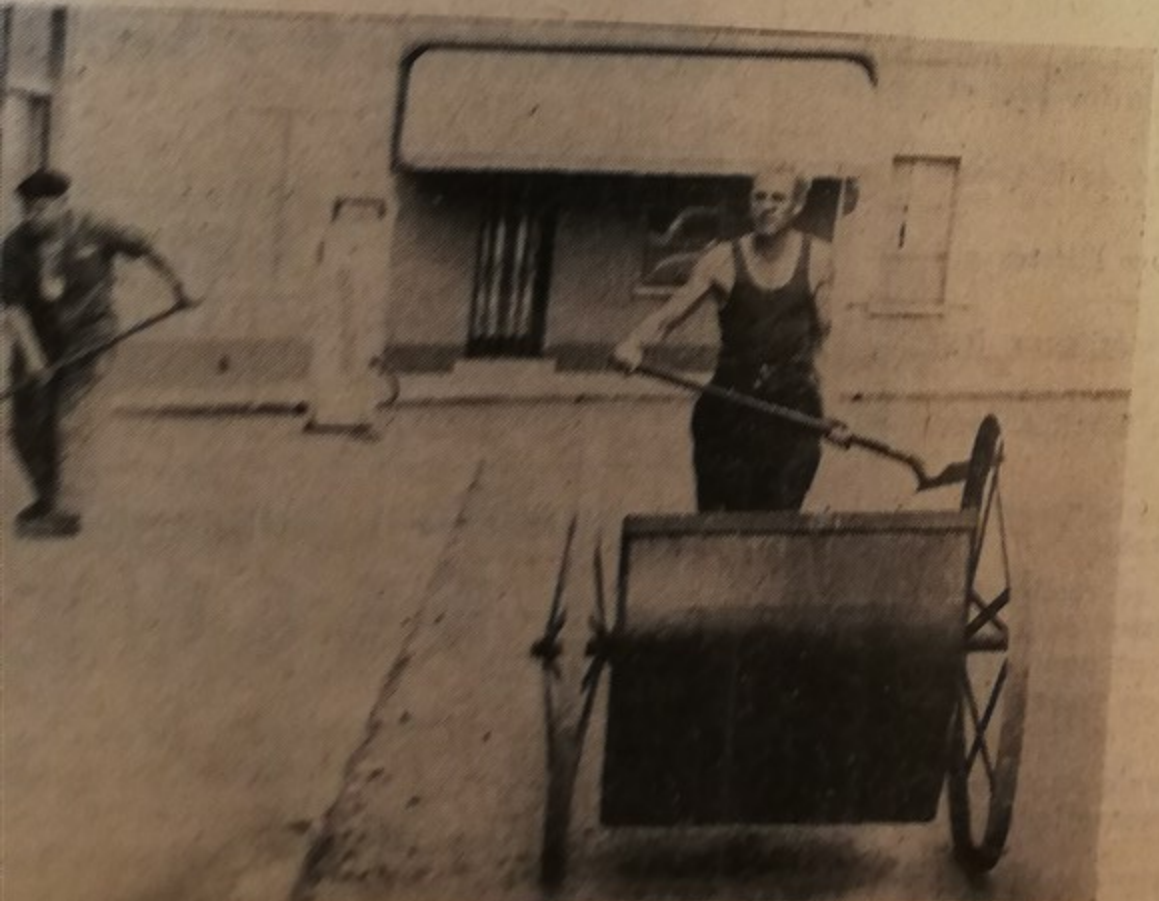
réfection des trottoirs place Auguste-Génie
