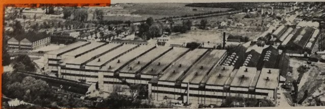
La plus importante usine de Montataire : Usinor
